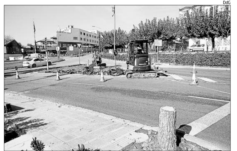
Treballs a la travessera, en què s'eliminarà un dels carrils.
